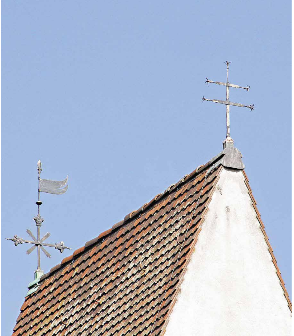
Turmkreuz und Wetterfahne – 1968 restauriert und wieder montiert.
